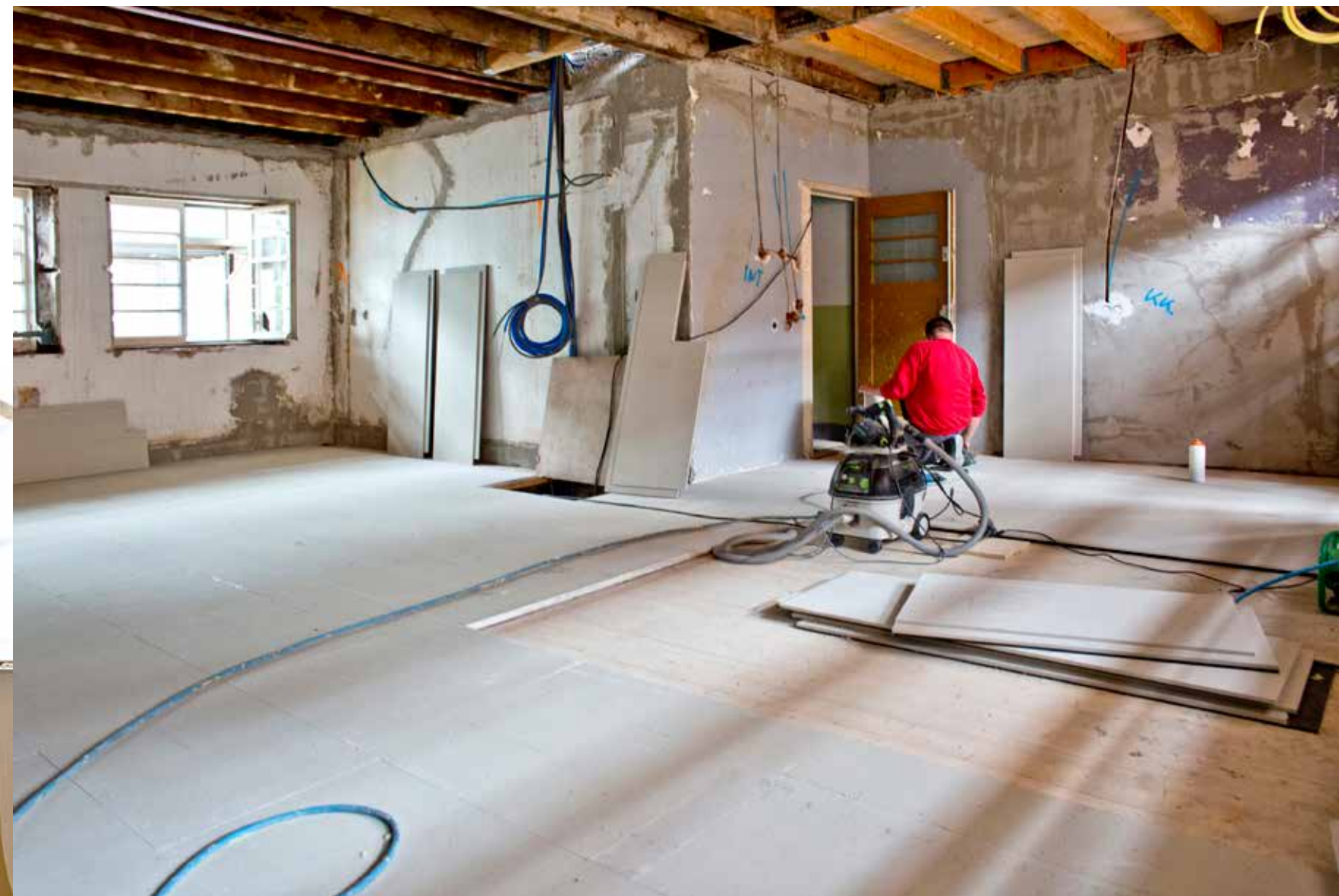
Het afdouwbedrijf monteert de fermacell gipsvezel vloerelementen type 2e26 met vilt.
