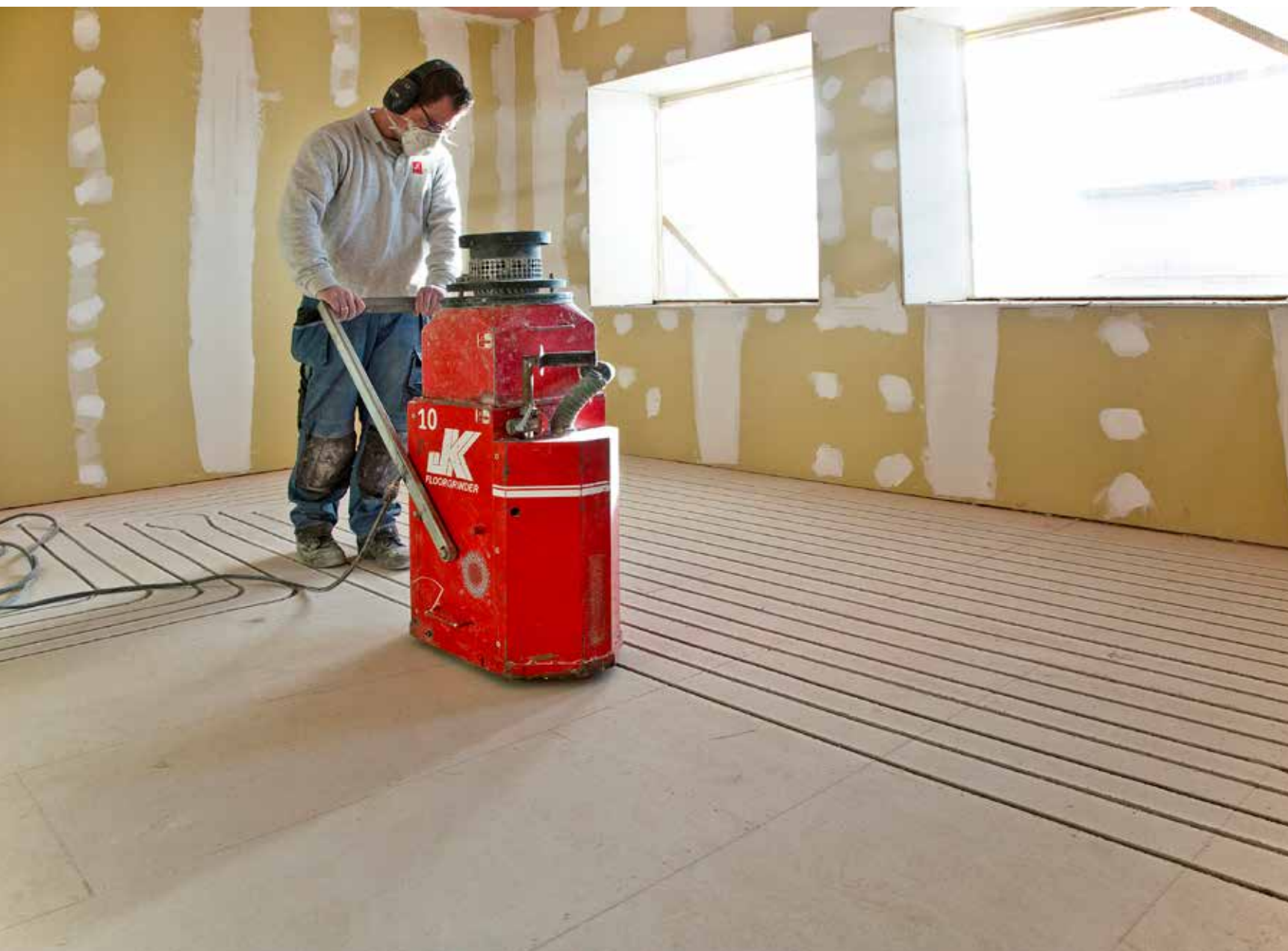
Ingeslepen vloerverwarming met de JK Floorgrinder.
